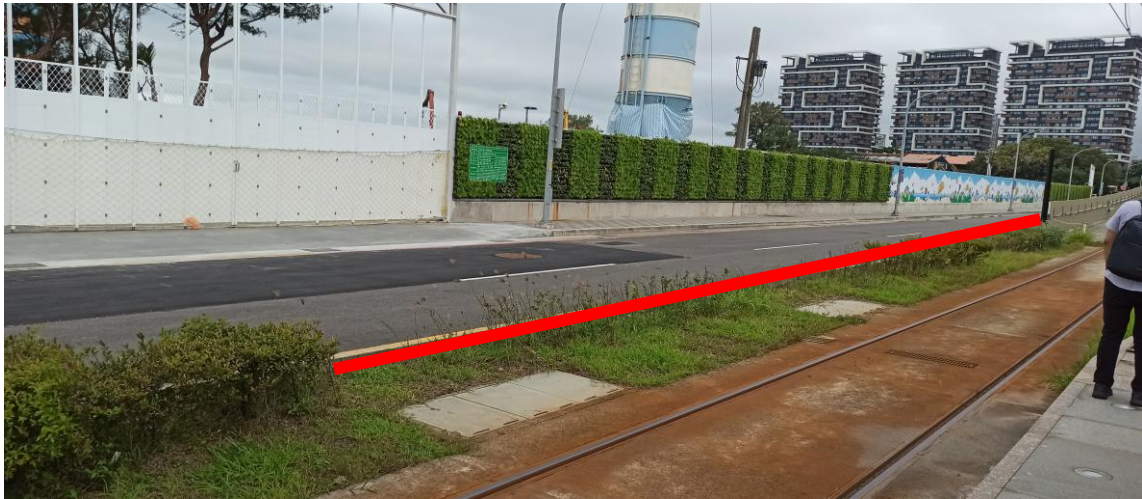
圖 2 淡海輕軌沙崙站與藍海橋引道間（北側）
