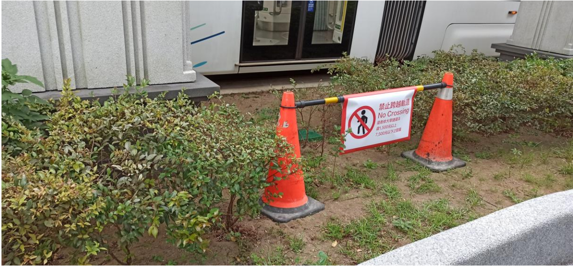
圖 6 淡海輕軌臨防止旅客跨越軌道臨時改善措施
