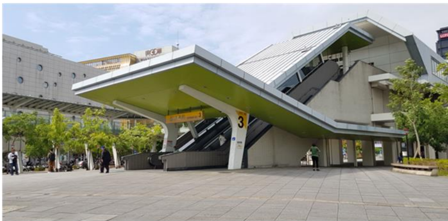
圖 8 臺北捷運文湖線劍南路站出口頂棚延伸
