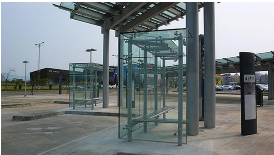
圖 12 高鐵新竹站外公車亭防風雨玻璃屋
