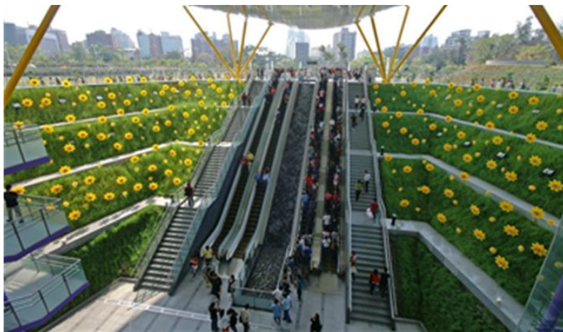
圖 21 高雄捷運中央公園站耐候型電扶梯
