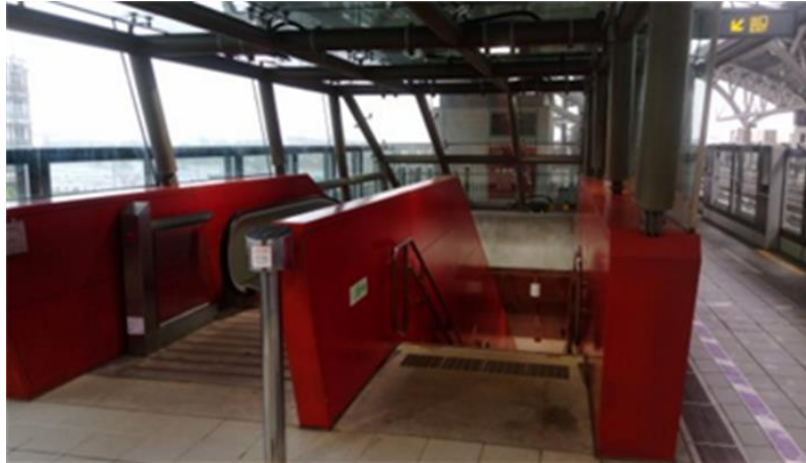
圖 23 機場捷運月台層電扶梯防風雨保護
