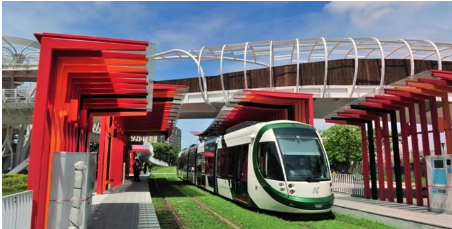
圖 6 高雄輕軌平面候車站以屋簷出挑方式防風雨
