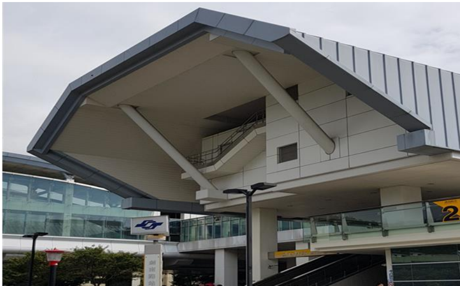
圖 17 臺北捷運文湖線劍南路站出入口出挑加長遮簷
