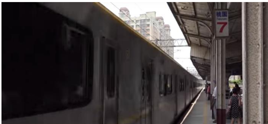
圖 15 臺鐵(架空線)系統月台遮簷出挑
