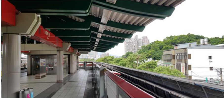
圖 14 臺北捷運唹哩岸站島式月台遮簷出挑防風雨
