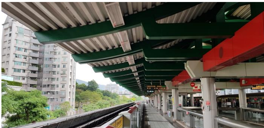
圖 4 臺北捷運淡水線忠義平面站屋簷出挑防風雨
