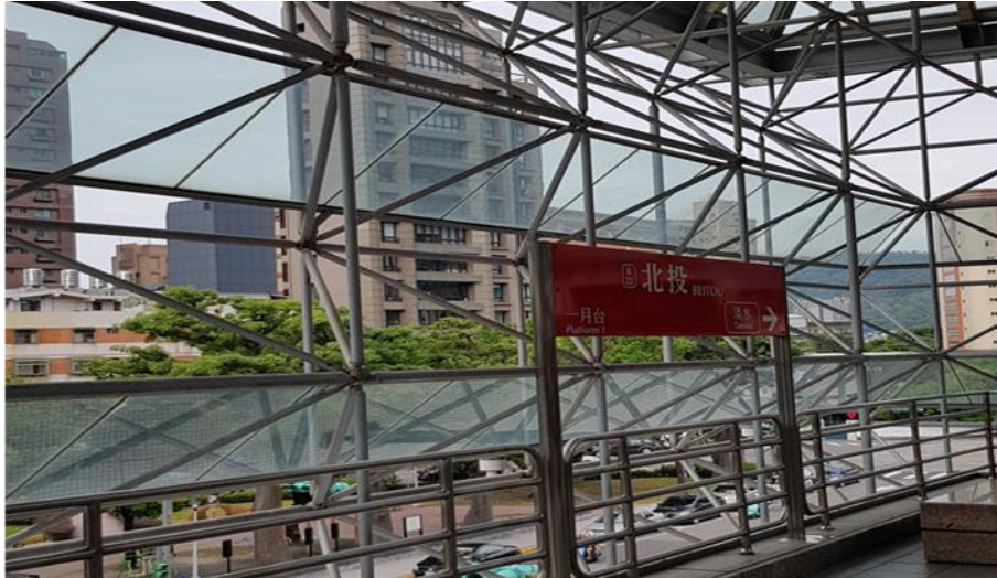
圖 10 臺北捷運淡水線北投站月台百葉推窗避雨及通風
