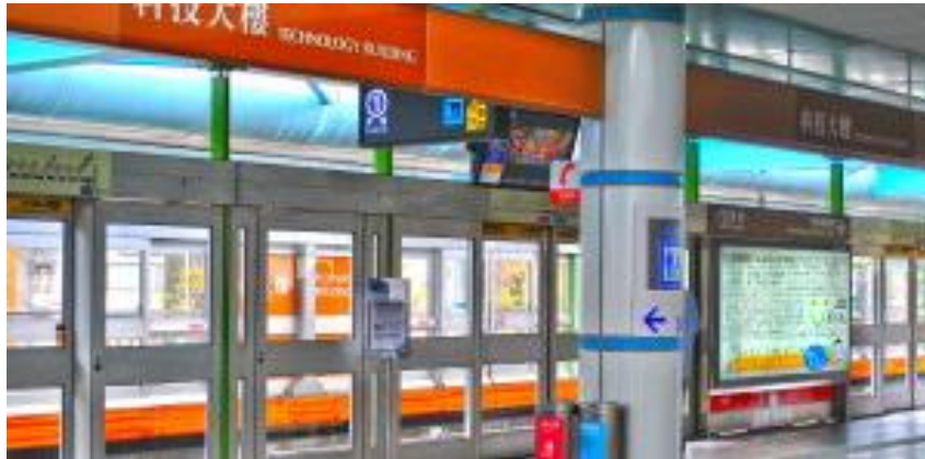
圖 3 臺北捷運文湖線科技大樓站月台門
