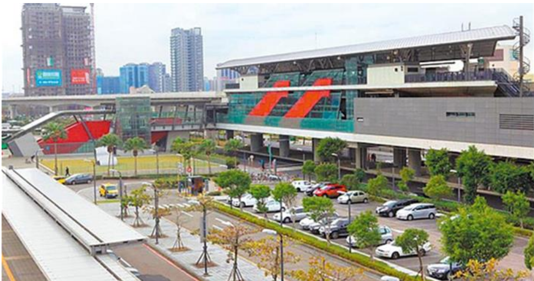
圖 1 機場捷運高鐵站外側帷幕牆防風雨
