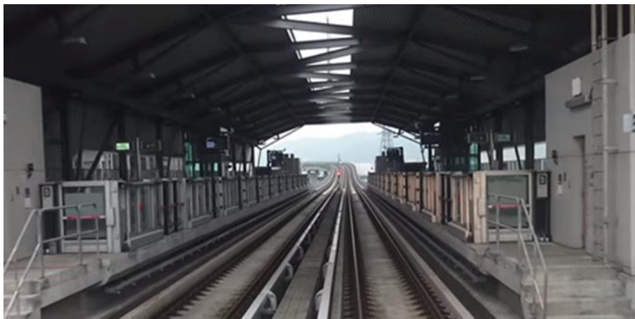
圖 13 機場捷運 A4 站側式月台遮簷出挑防風雨
