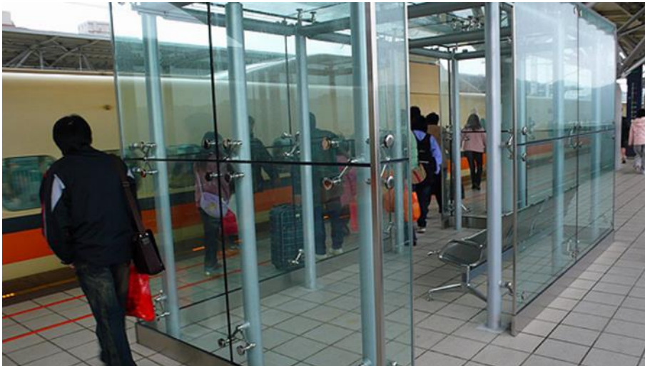
圖 11 高鐵新竹站月台防風雨玻璃屋
