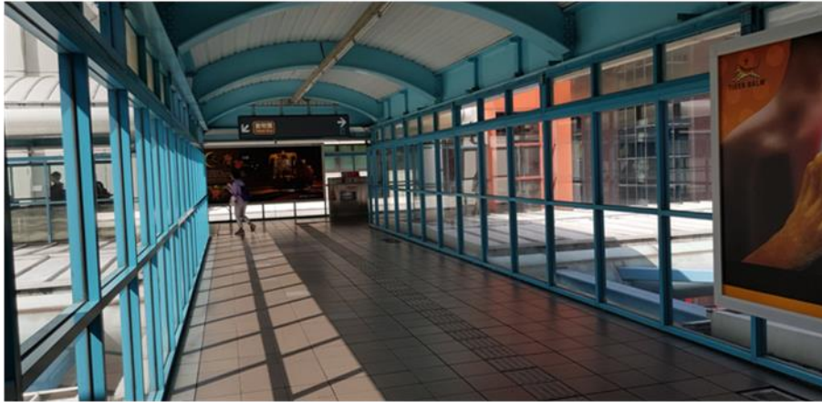
圖 7 高架車站站內通廊玻璃牆阻隔避風雨
