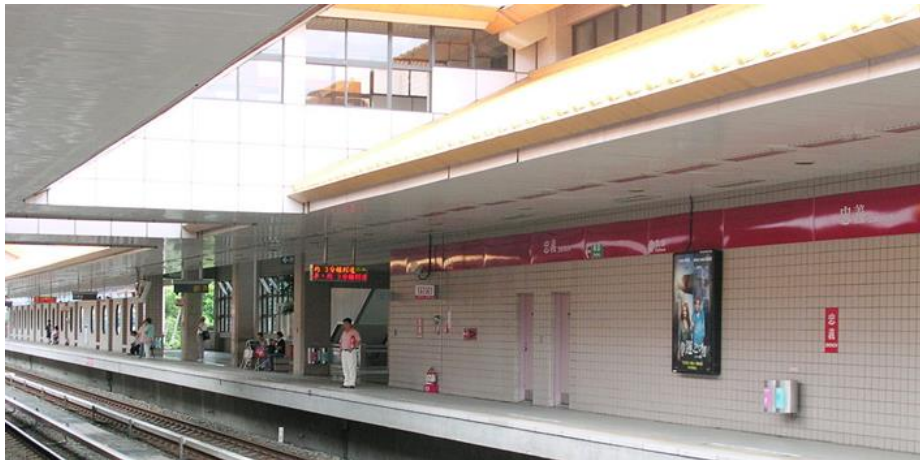
圖 4 臺北捷運淡水線忠義平面站屋簷出挑防風雨
