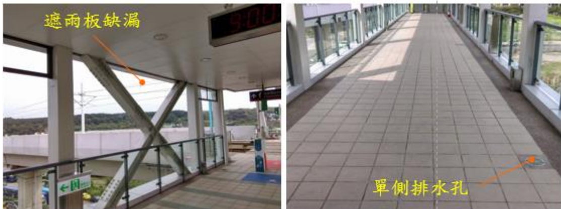
圖 29 遮雨板及排水孔改善示意圖
