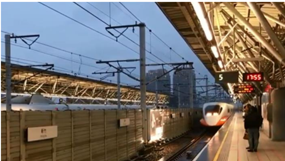
圖 16 高鐵(架空線)系統月台遮簷出挑
