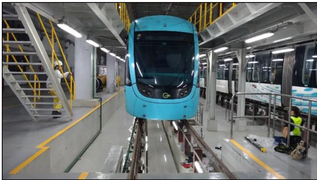
圖 21 淡海輕軌柱式檢查機坑
