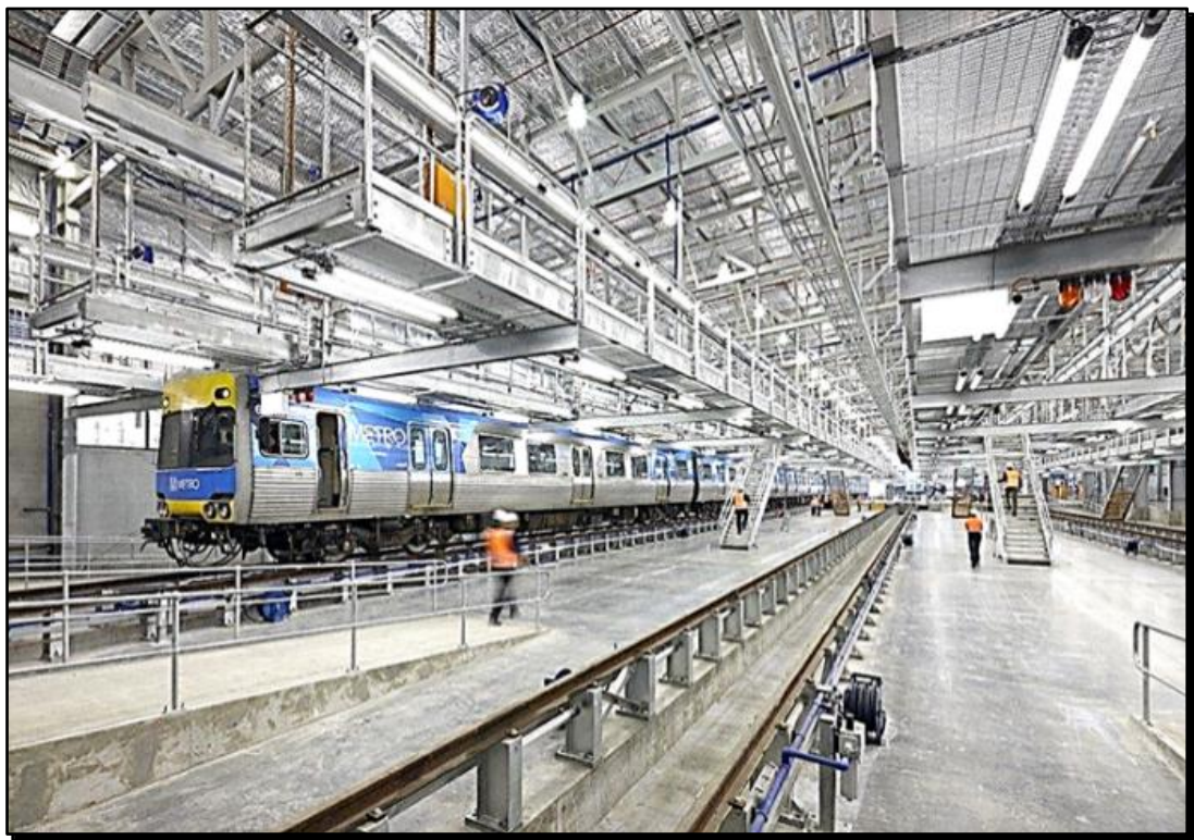
圖 24 懸吊式支撐檢修平台
