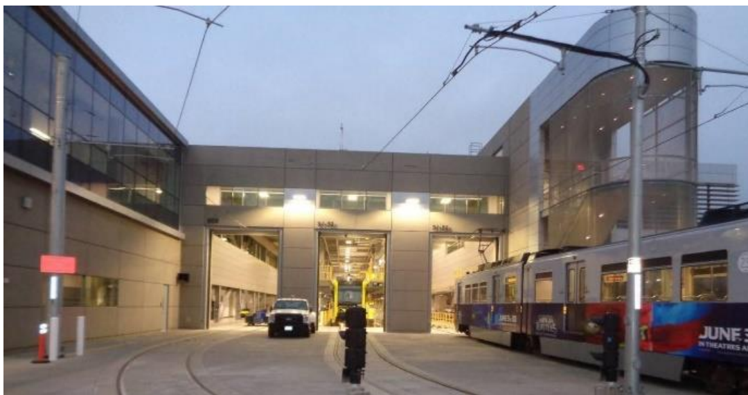
圖 4 廠區內無道碴軌道
