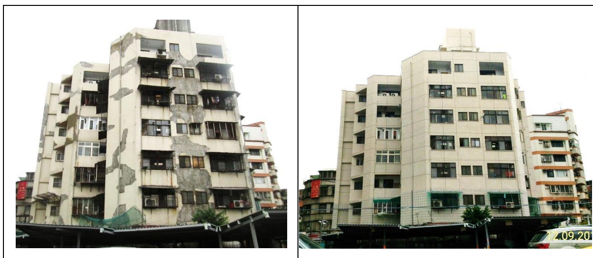
圖 3-19 永和永利段立面修繕整修前(圖左)與整修後(圖右)
