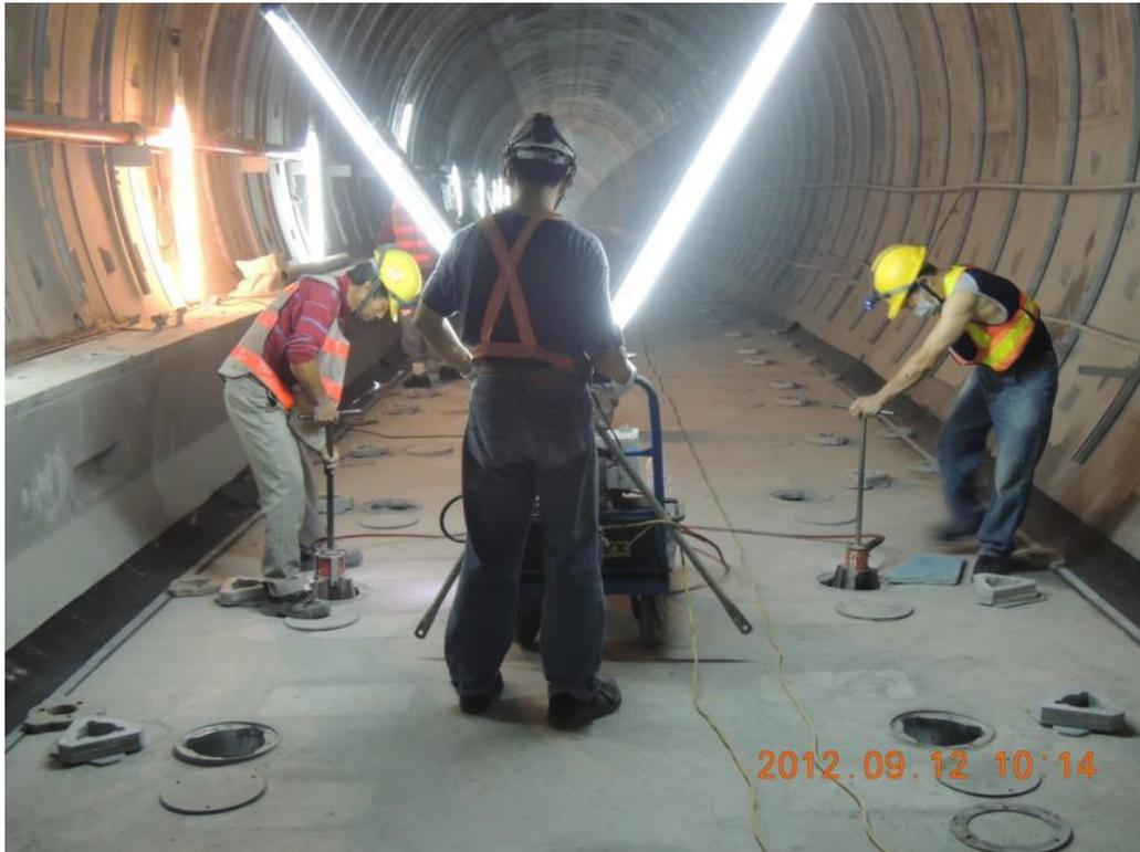
照片說明：浮動式道床頂昇作業
