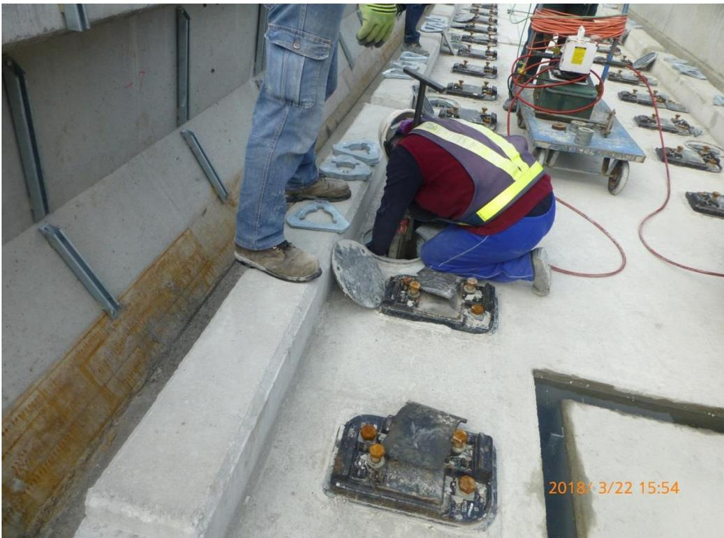
照片說明:高架段浮動式道床施作-鋼彈簧放置
