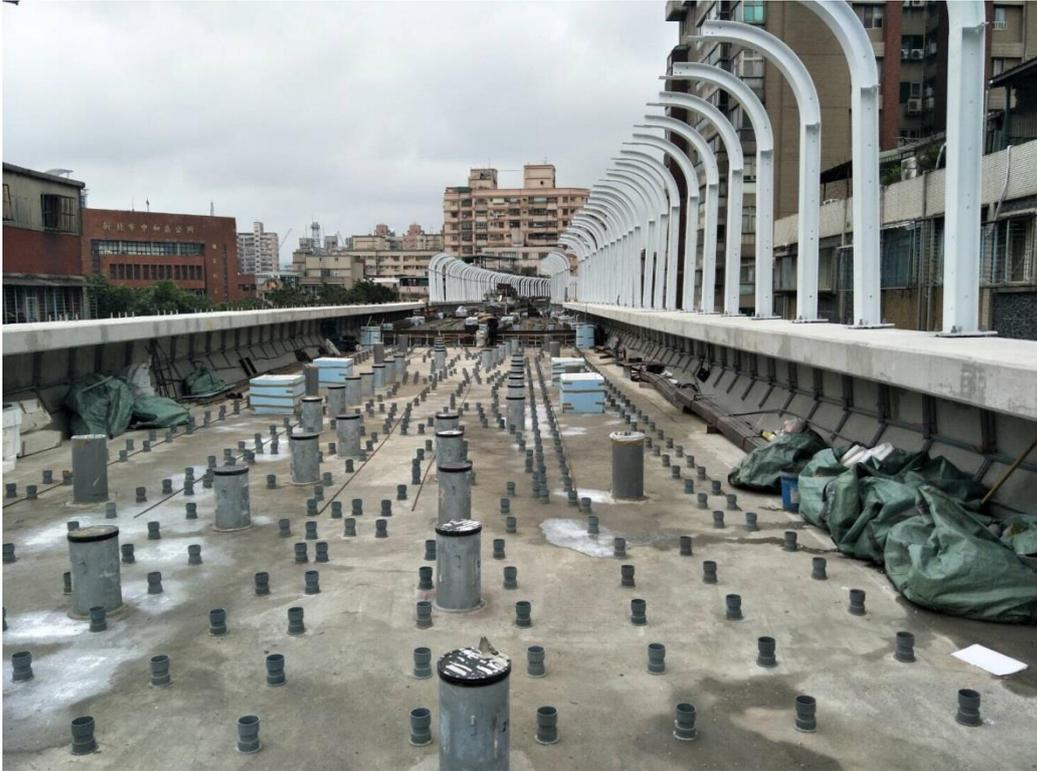
照片說明:高架段浮動式道床施作過程
