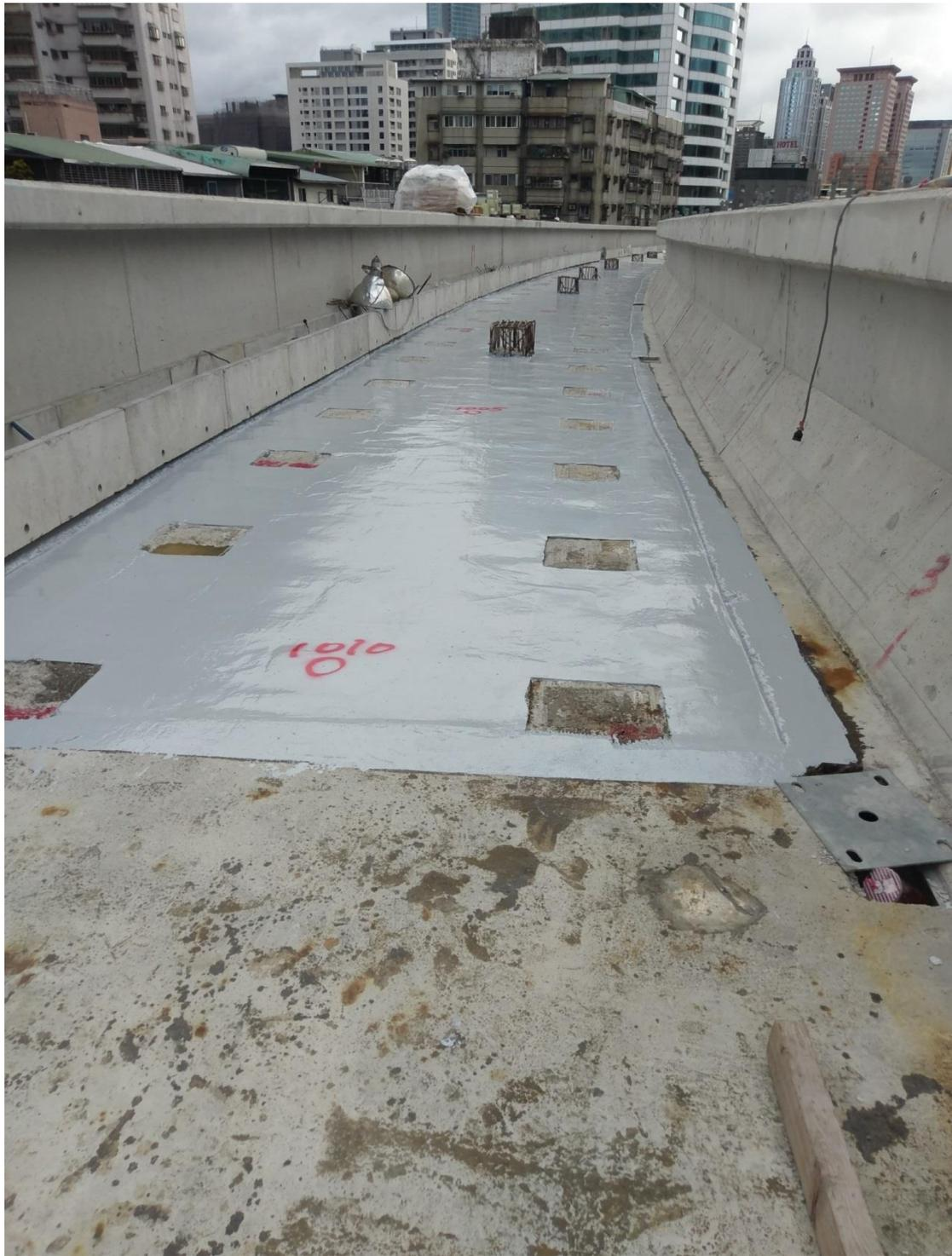
照片說明：削減保護層厚度後另行以EPOXY保護
