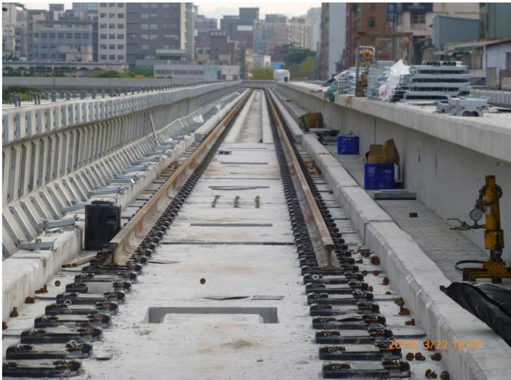
照片說明:高架段浮動式道床施作-基鈑及鋼軌安裝
