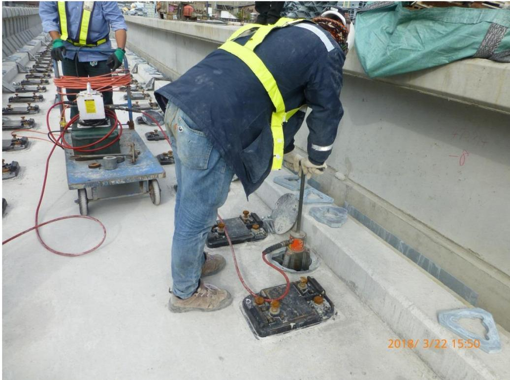
照片說明:高架段浮動式道床施作-浮動式道床頂昇作業
