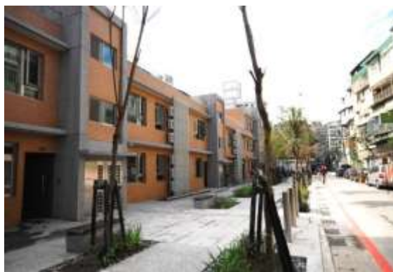
永和青年住宅完工現況照片
