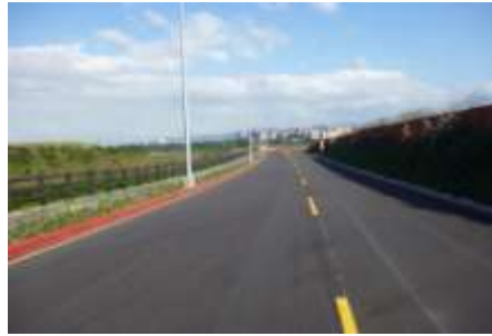
鶯歌大漢溪左岸環河道路
