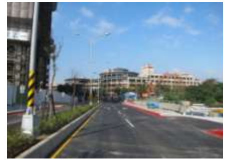
中和區光復國小20米聯外道路
