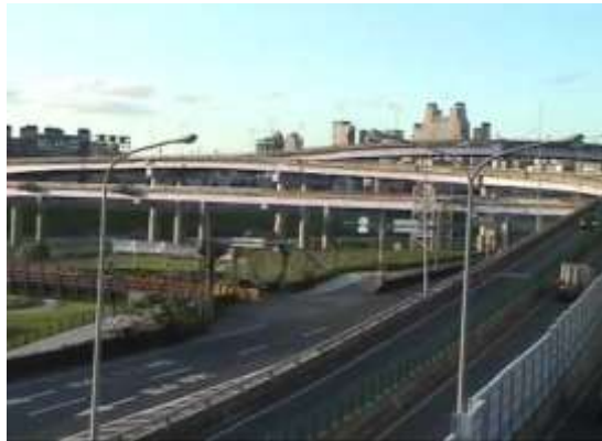
新北環河快速道路五重溪段(永和次系統)
