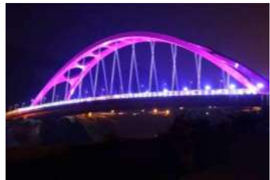
汐止新長安橋
