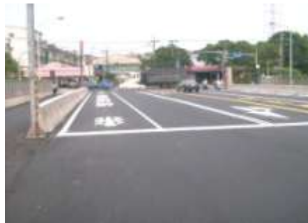
鶯歌區鳳鳴陸橋及周邊道路拓寬
