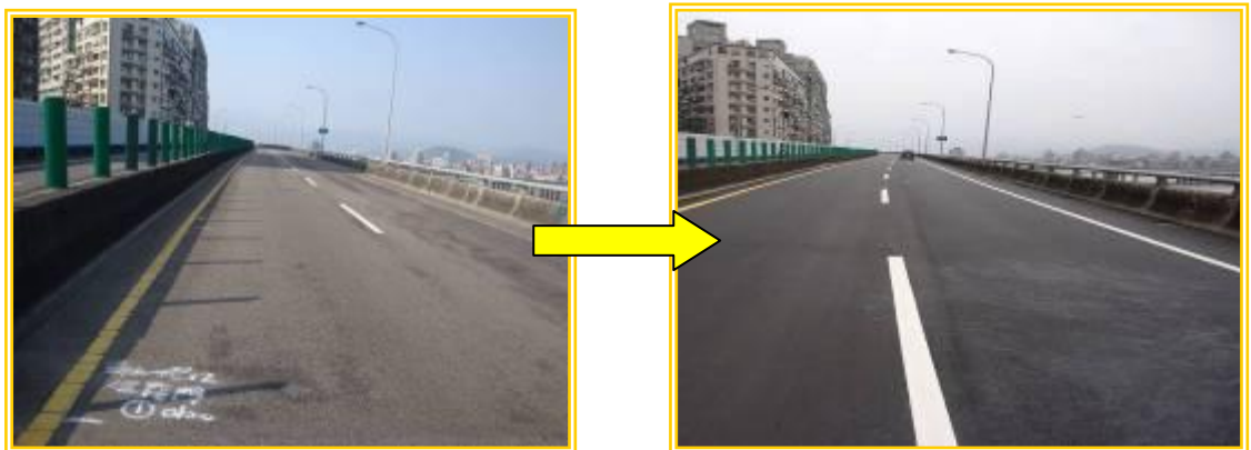
三重區新北環河快路道路施工前後
