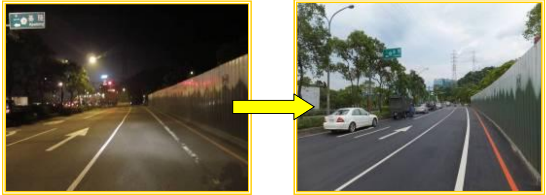
汐止區新臺五路施工前後
