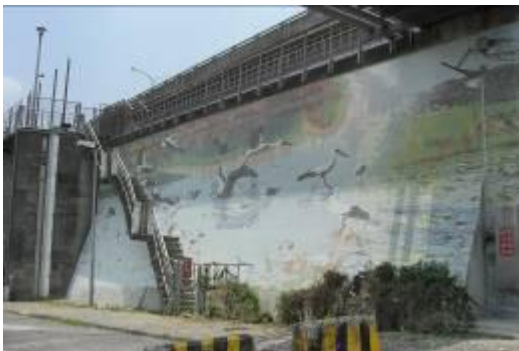
藍色公路周邊重點堤防段馬賽克拼貼美化
