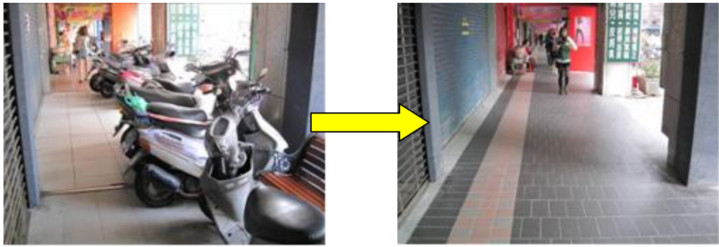
板橋區雙十路二段 170~172 號施工前後
