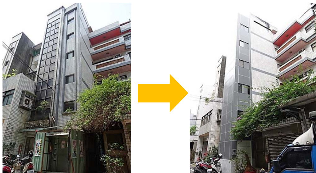
蘆洲區光華段增設昇降設備案施工前後對照圖
