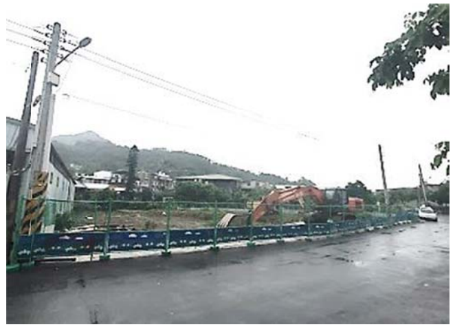
【排除占用後】山佳公兒六公園施工中
